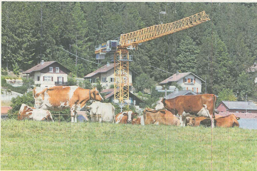
De nombreux chantiers sont visibles à la vallée de Joux, comme ici au Sentier. OLIVIER ALLENSPACH
